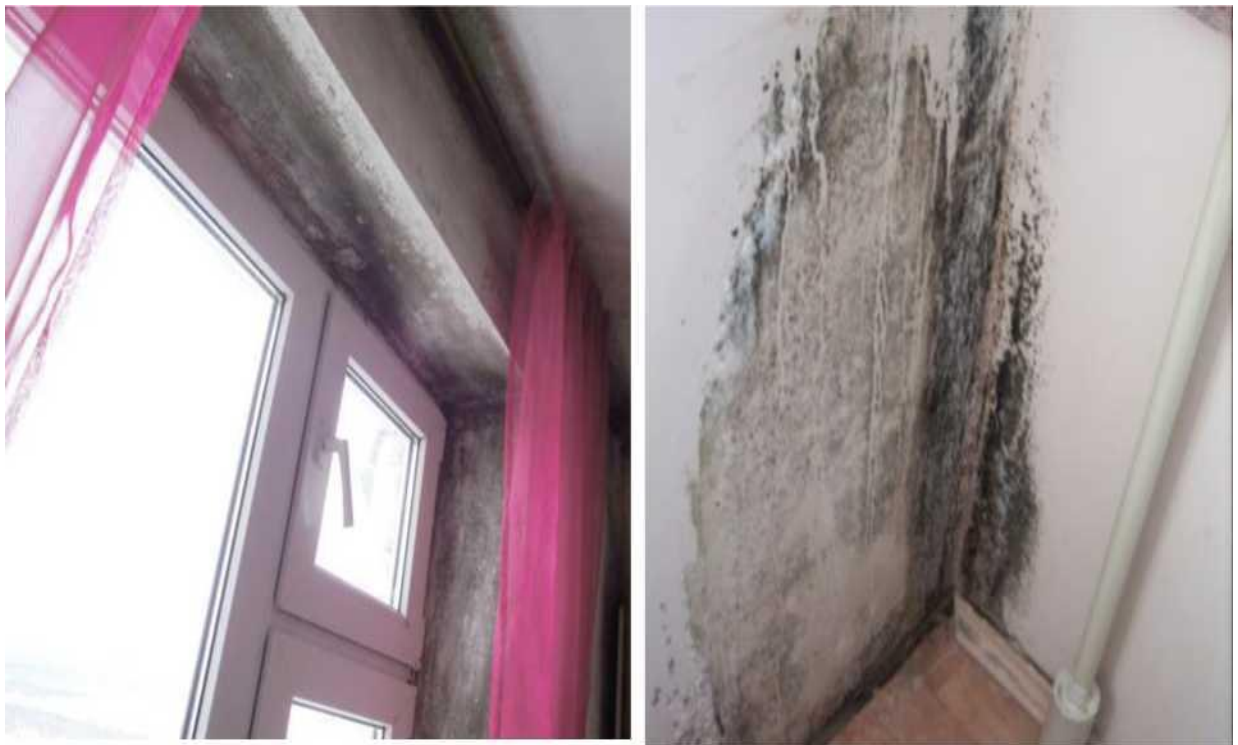
Рисунок 2.7 - Цвіль на віконних укосах у житловому будинку
