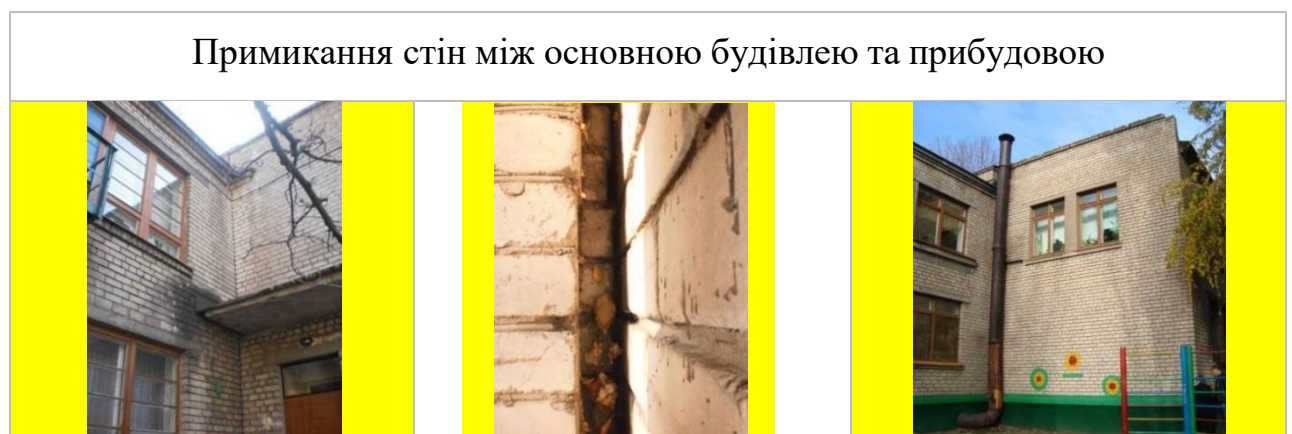
Рисунок 3.3 – Фрагменти фасаду будівлі
