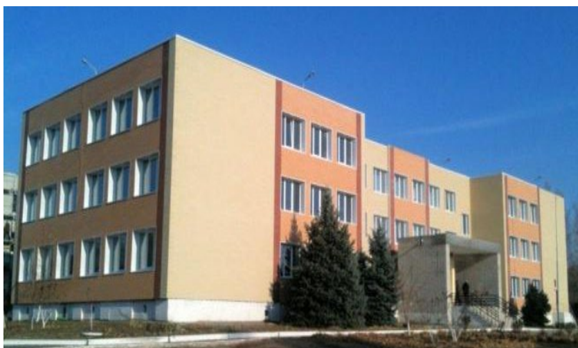
Рисунок 3.11 – Зовнішній вигляд будівлі ЗОШ №109 м. Запоріжжя
