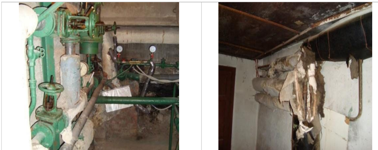
Рисунок 3.6 – Вузол теплового ведення та магістральні трубопроводи
