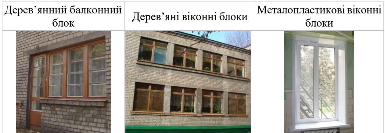
Рисунок 3.9 – Вигляд вікон будівлі
