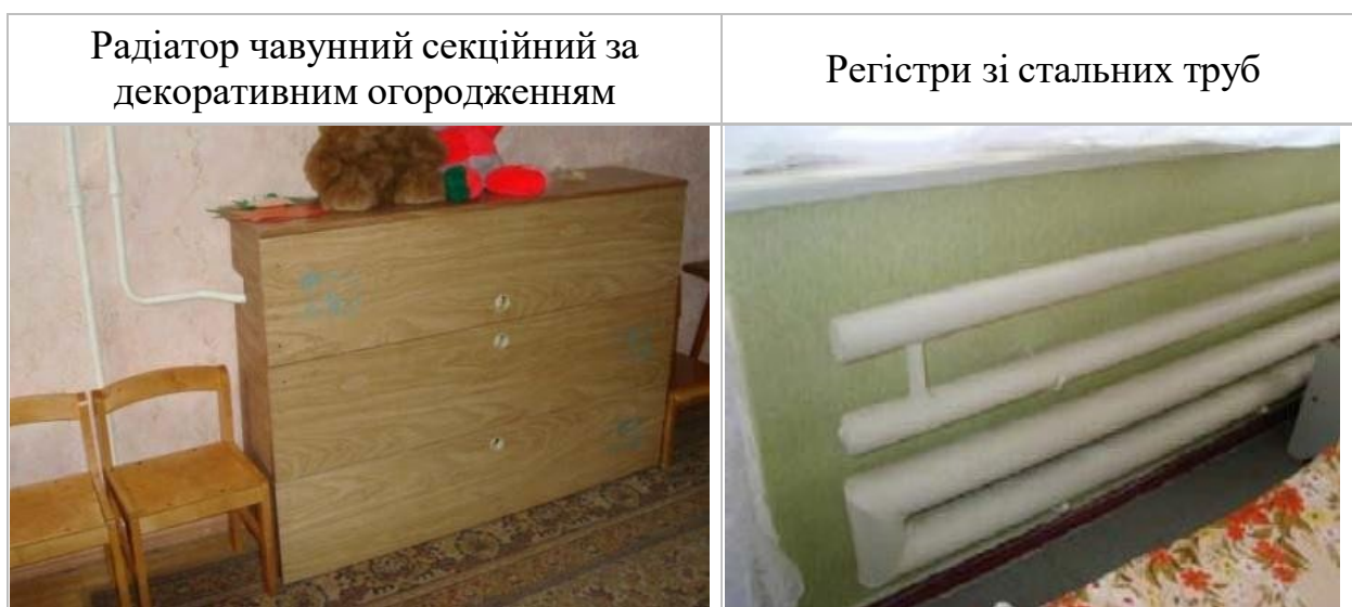
Рисунок 3.7 – Елементи внутрішньої системи опалення будівлі
