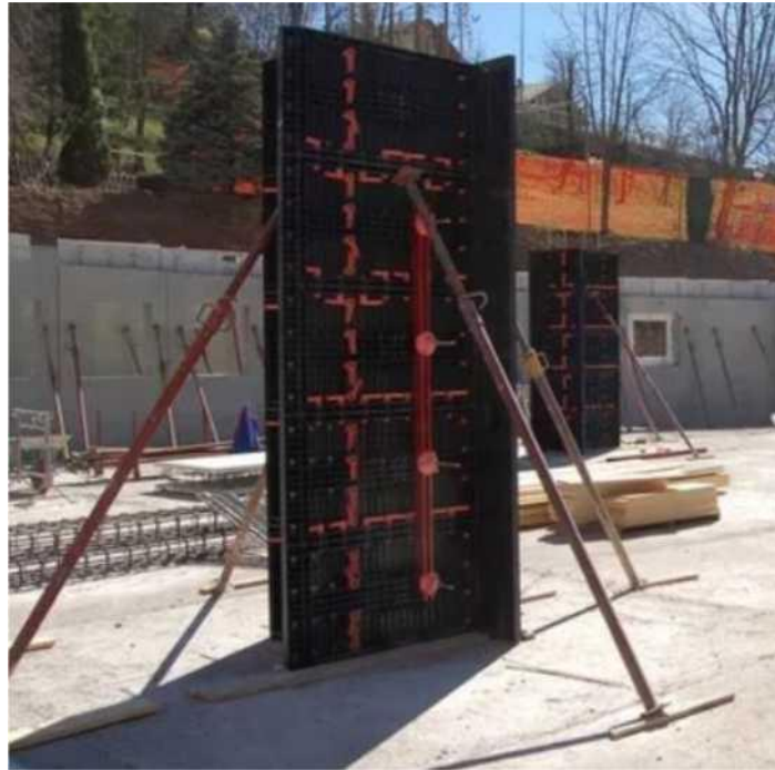
Рисунок 2.10 - Дрібнощитова опалубка системи "STAR-ТЕК" для колон
