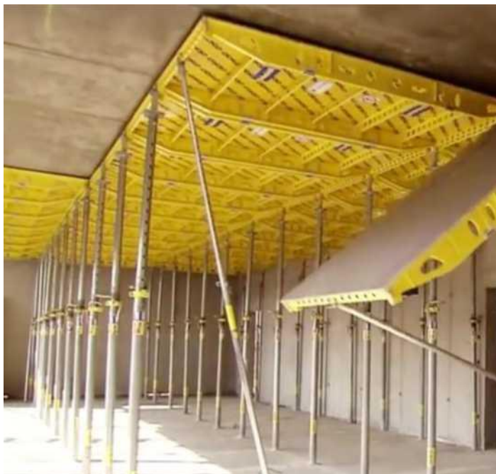
Рисунок 2.11 - Опалубка системи "DOKA-FLEX для перекриттів
