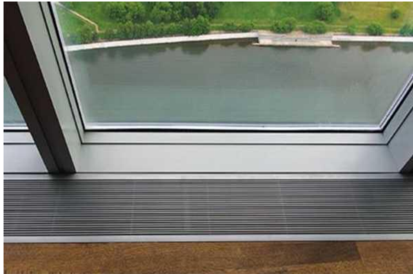
Рисунок 1.5 - Вбудований у підлогу конвектор
