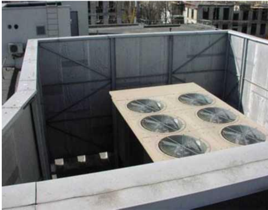
Рисунок 1.1 - Шумопоглинаючий екран охолоджуючого чиллера
