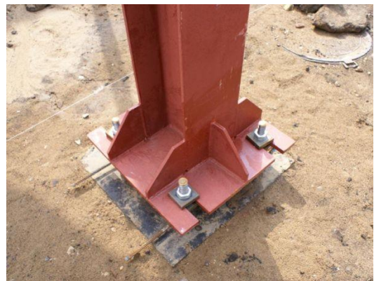
Рисунок 3.1 – Монтаж металевих колон
