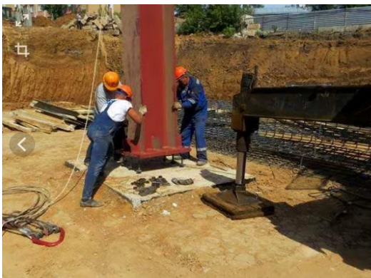
Рисунок 3.1 – Монтаж металевих колон
