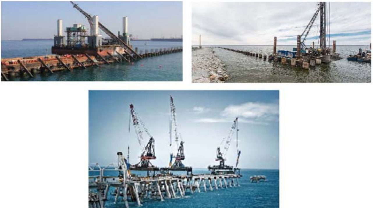
Рисунок 3.11 – Влаштування пальових споруд
