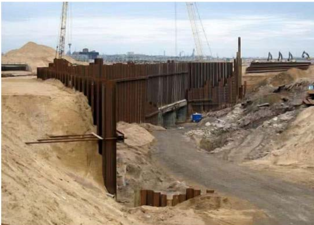
Рисунок 3.7 – Будівництво за допомогою металевого шпунта
