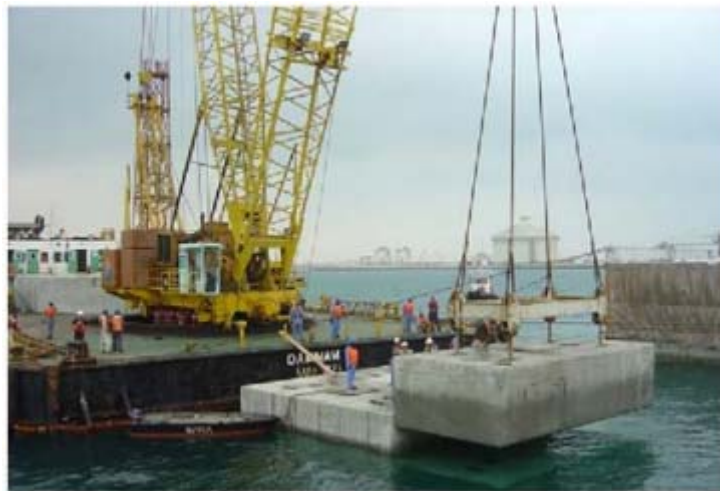
Рисунок 3.8 – Способи встановлення масивів в кладку огорожувальної споруди
